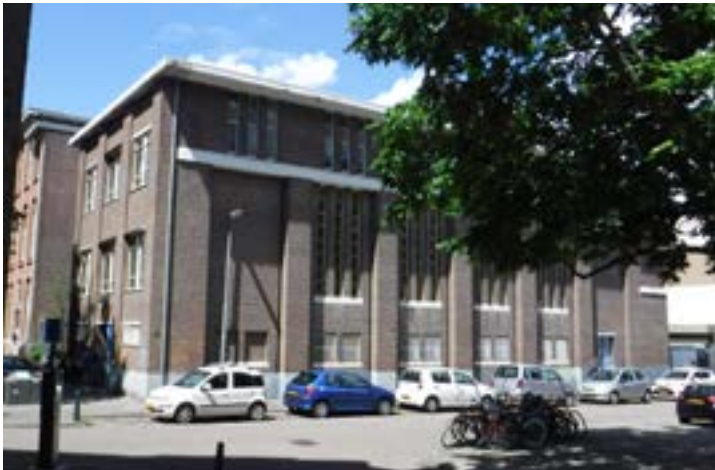
Baan 159: Onderstation Stedin, behoud
